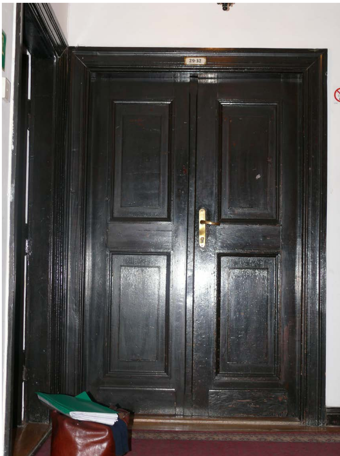
Drzwi podwójne brązowe – przejście z bud 29 do 31 przy sali
